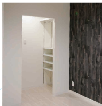
◀クローゼットの扉を撤去し、オープン収納ですっきりとした空間になりました。
