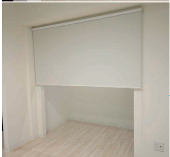
▲サンルームの扉を撤去し、ロールスクリーンに変更することで、交換・メンテナンス費が割安に。
