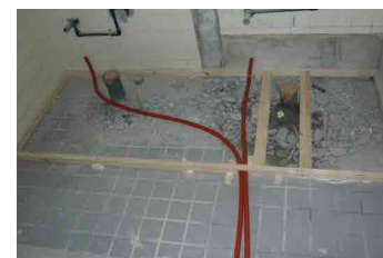
▲普段はなかなか見えない内部の配管にも注意が必要。
